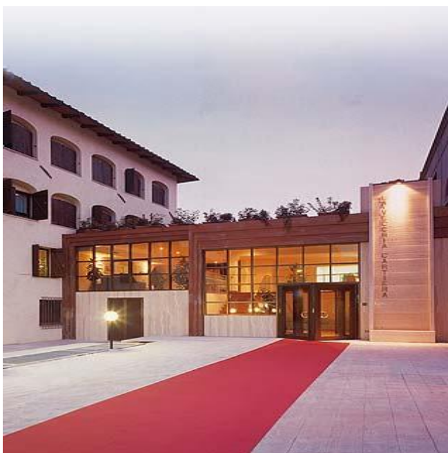
Reconversion d'une ancienne papeterie en Italie
